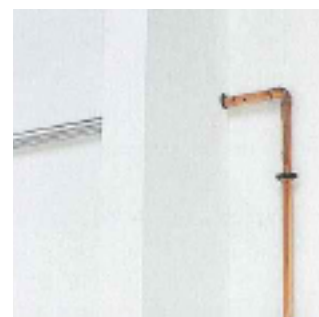
Tubería del gas entrando en una cámara cerrada, correctamente envainada
