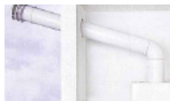
Conducto de evacuación directa al exterior, a través de la fachada.
