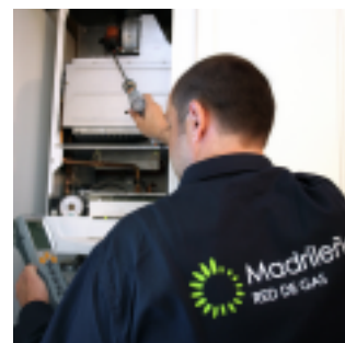
Análisis de combustión de un calentador.
